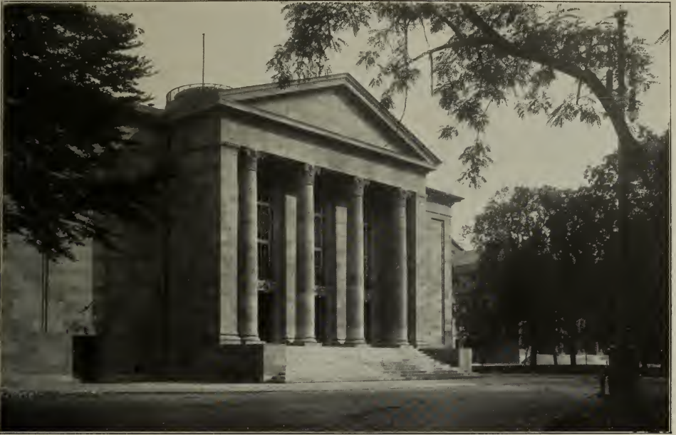
Die neuen Stuttgarter Hoftheater: Das kleine Haus. Architekt: Prof. Max Littmann, München Nach rechts hin (vom Beschauer aus) das Verwaltungsgebäude, das die Verbindung mit dem großen Hause herstellt
